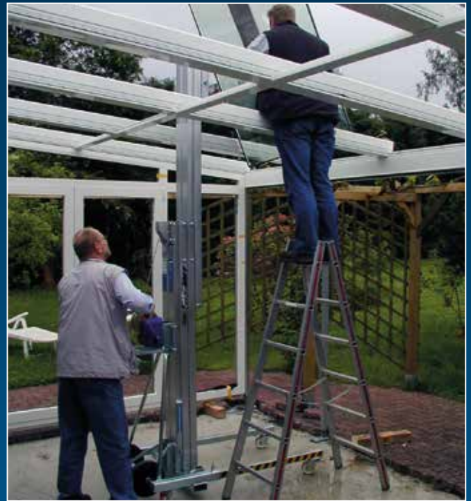
Modelo LMC_S4 – Acristalamiento en techo con dispositivo de ventosas
